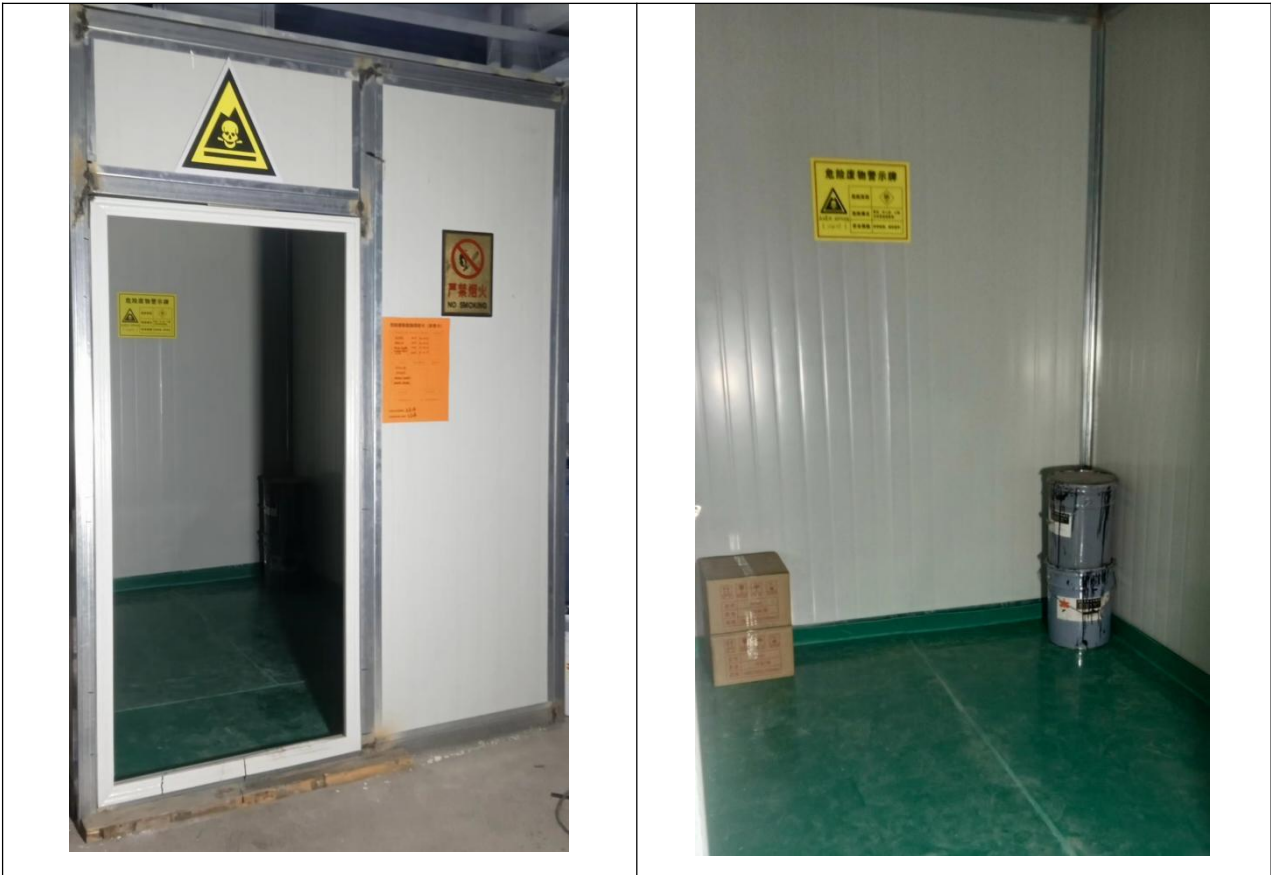
图 4-3 危险废物暂存仓库
