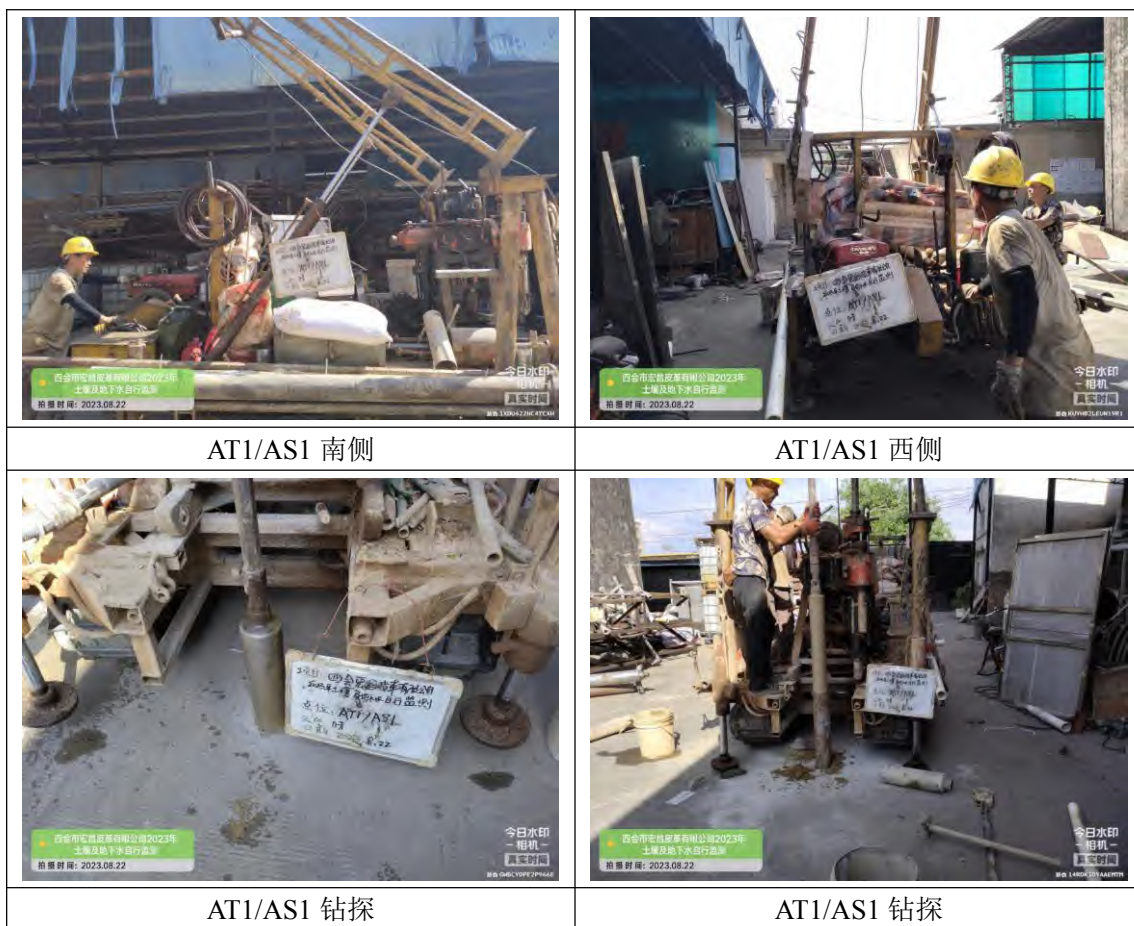
图 5.2-1 深层土壤点位钻探现场照片
