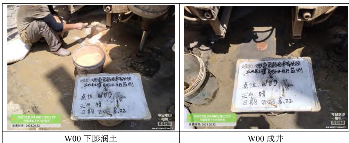
图 5.2-2 地下水监测井建井现场照片
