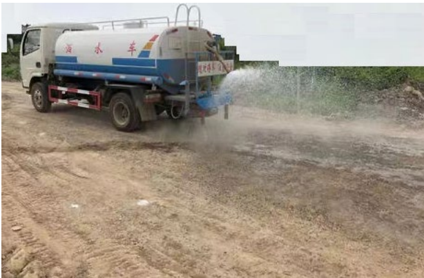
施工洒水抑尘
