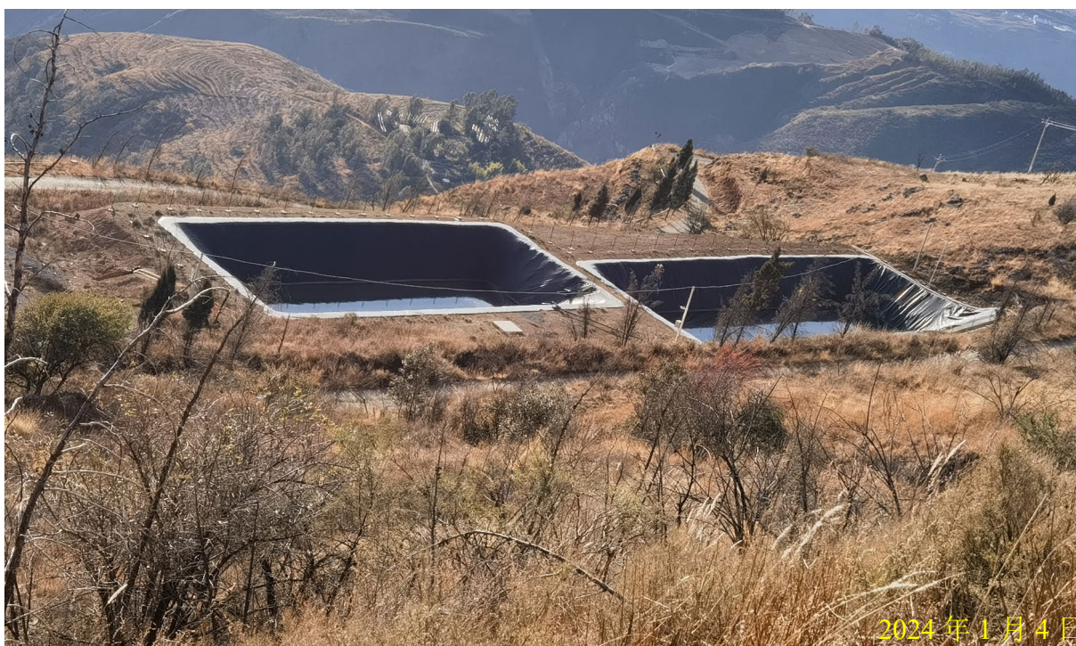
尾水氧化塘（仅作雨天储存污水处理站处理后的废水用，2个，1个2400m 3 ，另1个3000m 3 ）
