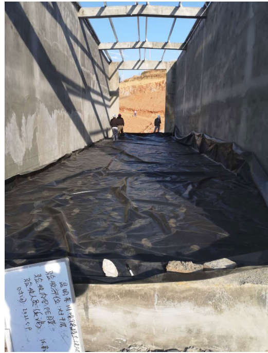
污水处理站现场施工照片
