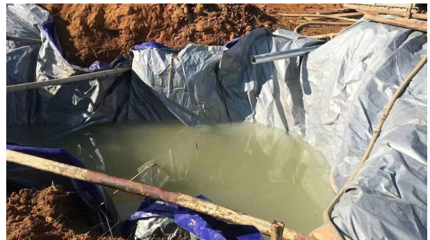
施工简易沉淀池
