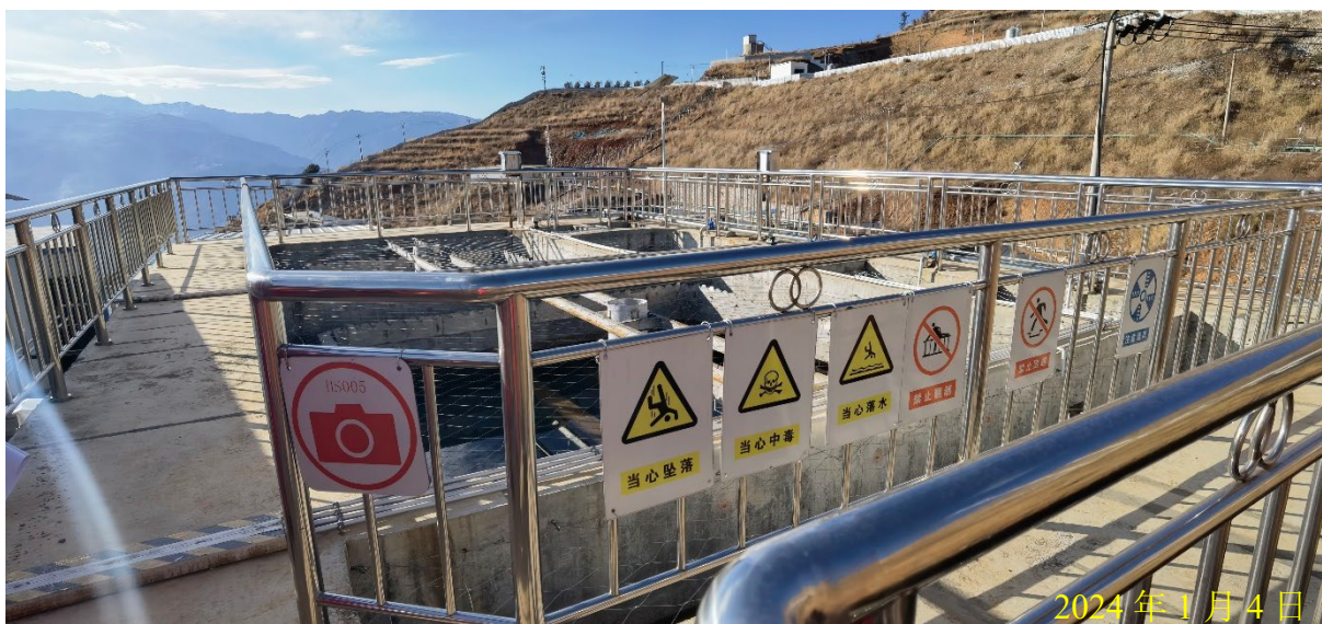
深度处理池及标识牌
