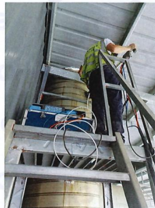
DA001 RTO 炉废气处理后采样口
