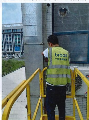
厨房油烟处理后采样口
