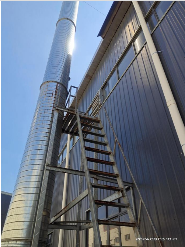
DA002 采样口、采样平台、处理设施照片
