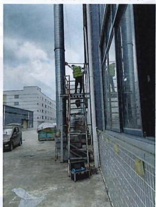
DA003 纸塑复合废气处理后采样口
