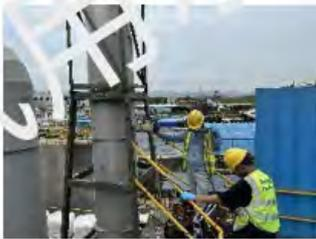
吹脱废气与蒸盐废气处理后采样口
