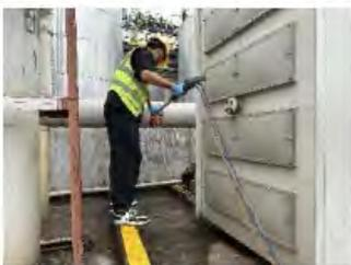
罐区废气处理后采样口 (DA036)
