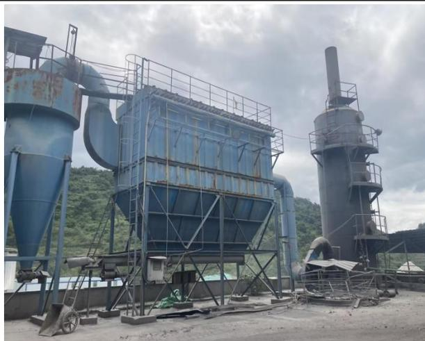
脉冲式布袋除尘器+双碱法脱硫+排气筒
