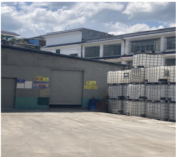
厂区危废暂存间
