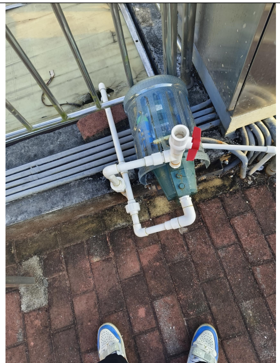
采样泵、手工采样口
