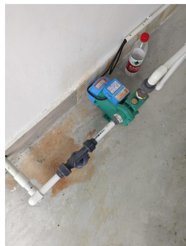
采样泵、手工采样口
