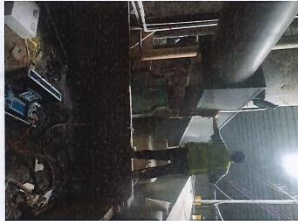
池炉废气处理后采样口
