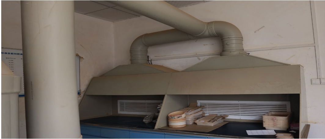
依托原有打磨抛光集尘器
