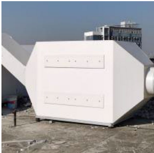
扩建有机废气活性炭吸附装置
