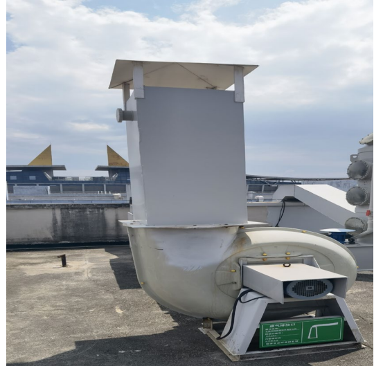
扩建 23m 高的有机室 2#排气筒
